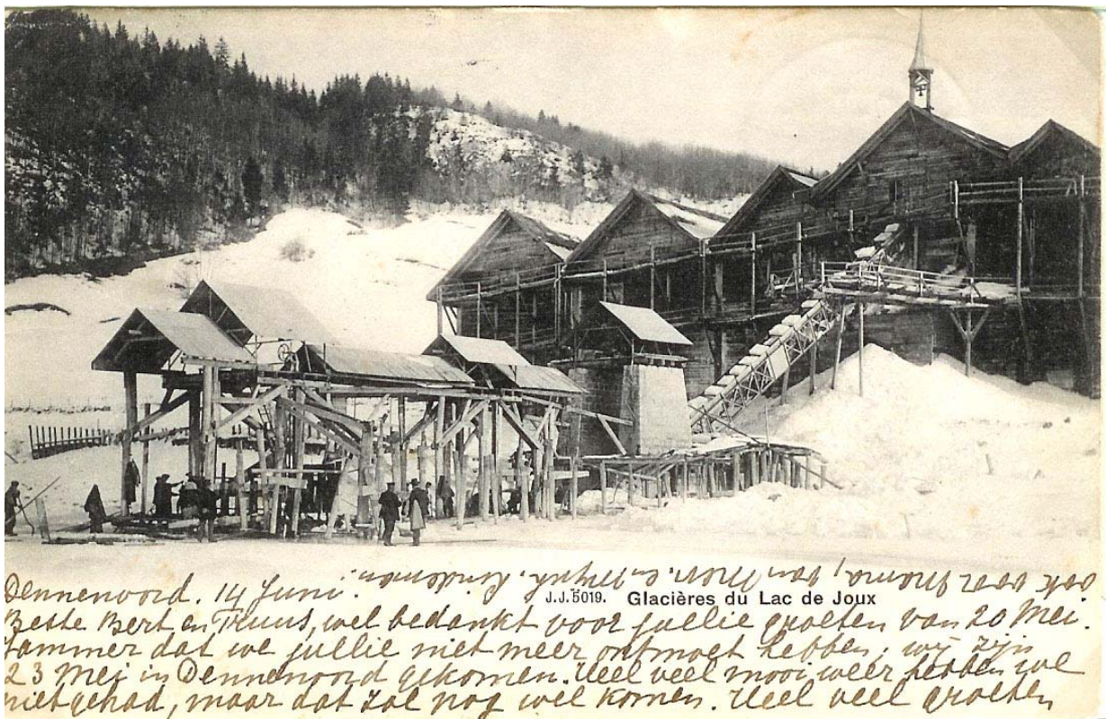
Vue sur les installations de sciage et de la prise en charge par l'élinde.
