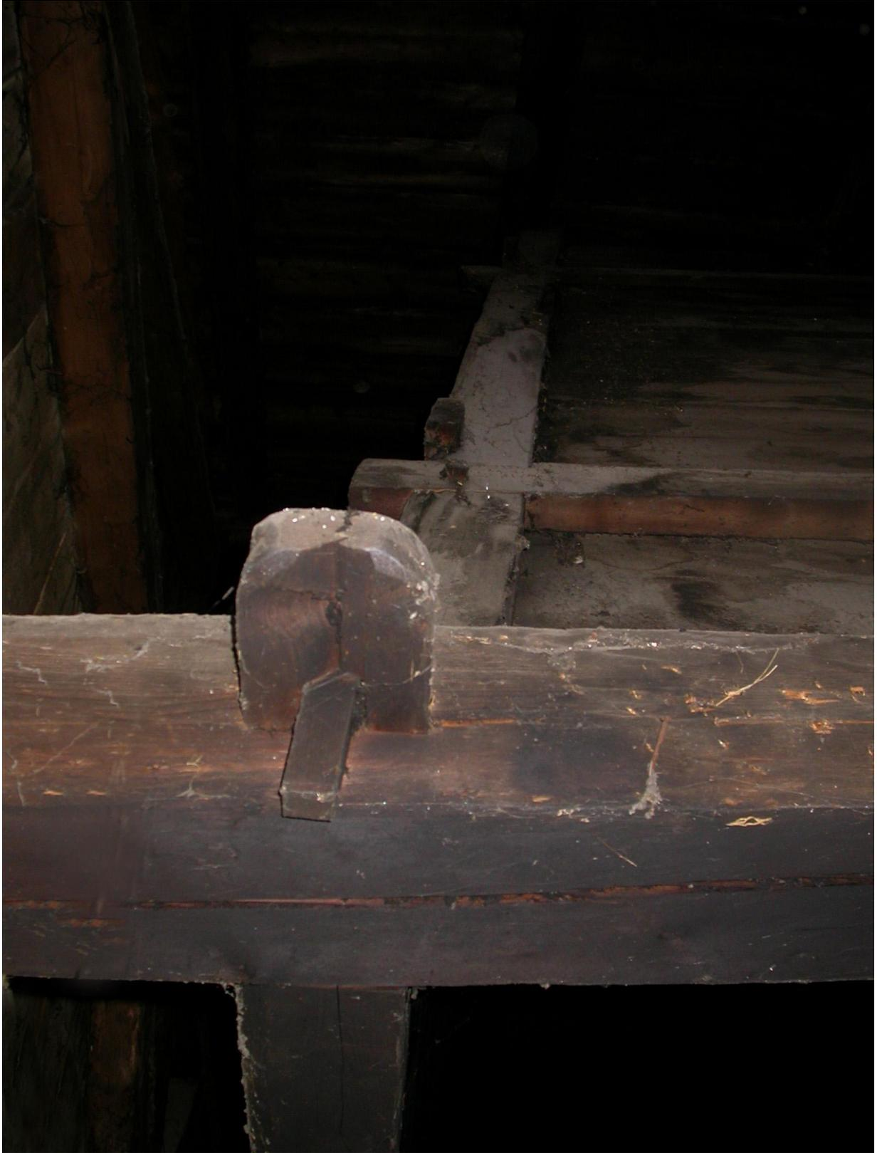
Jointure de deux poutres à l'angle.
