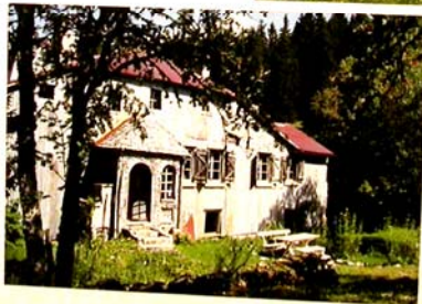
le porche d'entrée et le jardin la façade donnant sur la Vallée de Joux
