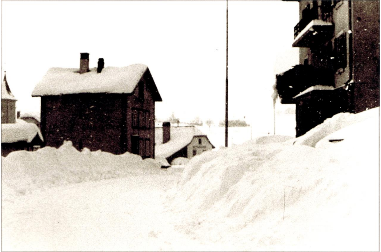
Retour sur nos pas et fin de la promenade. A droite chez Loudgi, à gauche chez Meyer, soit la forge. Au fond, la boulangerie. L'église est à l'extrême gauche.
